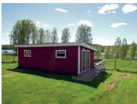
Servicebyggnad med toaletter
