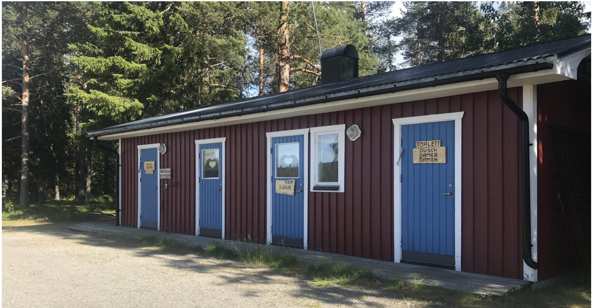
Servicehus med kök, tvättstuga, VA, dusch, bastu.
